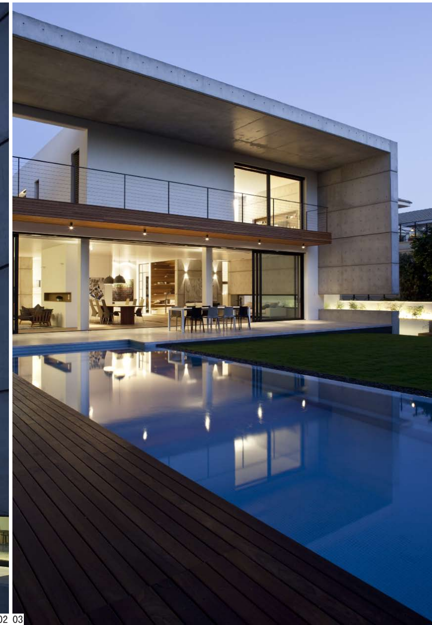
01 建筑外观 02-03 外观局部
